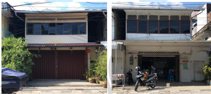
Gambar 1. 3 Bangunan Pertokoan Pecinan Koridor Jl. Pandansari
