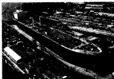
Gambar. 2.9. Graving dock (atas kebaikan National Steel dan Pembuatan Kapal).
