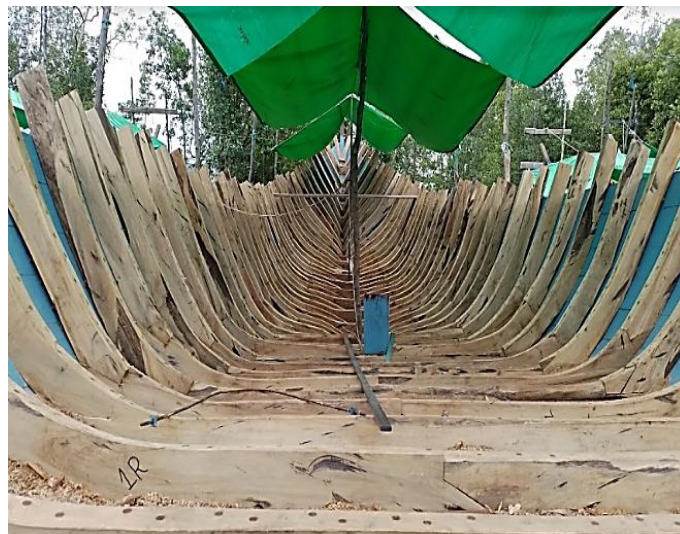
Gambar 2. 2 Konstruksi gading kapal kayu (Sumber:Dokumentasi Pribadi)
