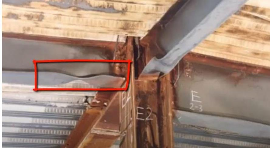
**Gambar 2. 22** Batang tekan yang mengalami tekuk lokal
