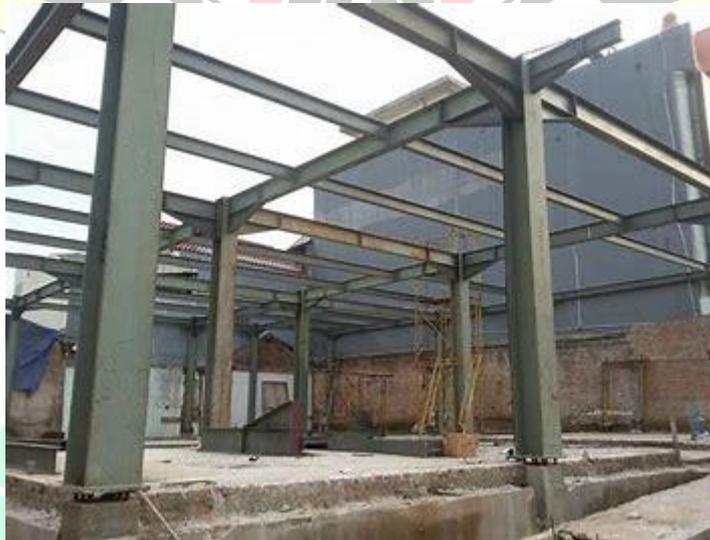
**Gambar 2. 18** Struktur kolom menggunakan material baja
