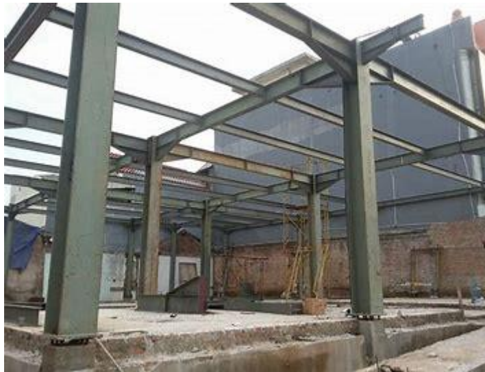
Gambar 2. 18 Struktur kolom menggunakan material baja
