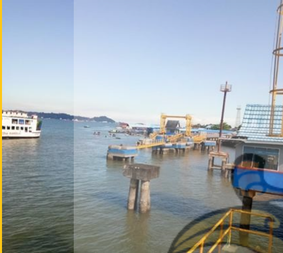
Pelabuhan Ferry Penajam Paser Utara
