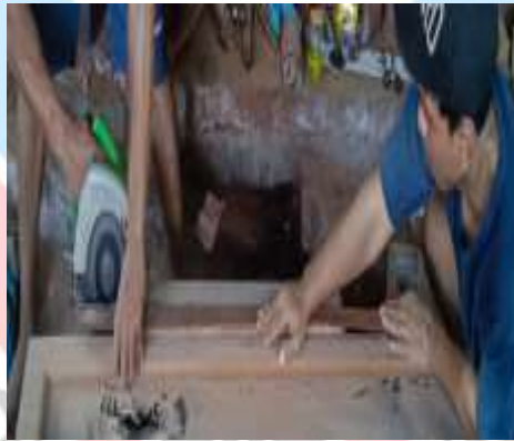
Gambar 4. 6 Pemotongan Menggunakan Mesin circular saw (Sumber: Dokumentasi Pribadi, 2025)
