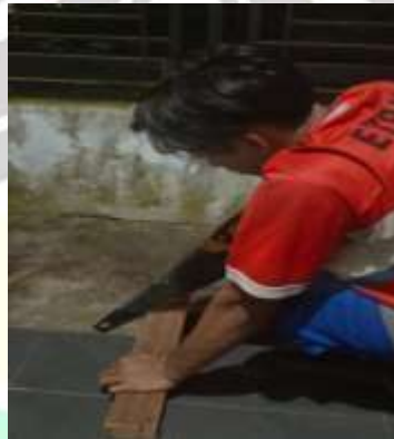
Gambar 4. 7 Pemotongan Menggunakan Gergaji (Sumber: Dokumentasi Pribadi, 2025)
