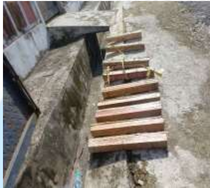
Gambar 4. 10 Pemasangan laminasi bambu dan kayu meranti (Sumber: Dokumentasi Pribadi,2025)
