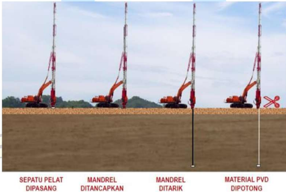
Gambar 2.5 Urutan Pemasangan PVD (Sumber: PT. Teknindo Geosistem Unggul)
