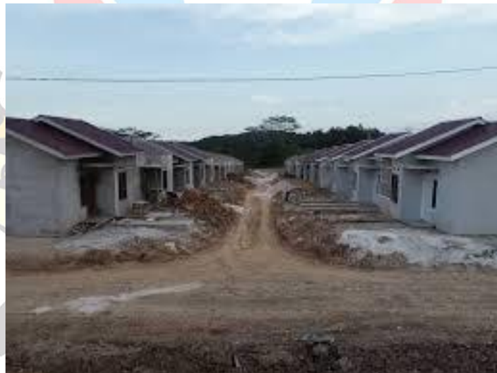
Gambar 1.1 Kondisi Eksisting Kawasan Perumahan
