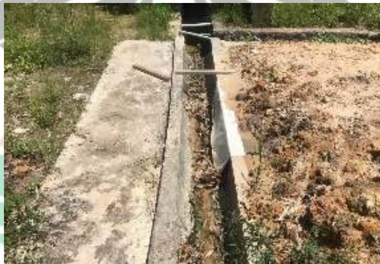
Gambar 1.2 Saluran eksisting pada kawasan Fakultas MIPA yang bersedimen
