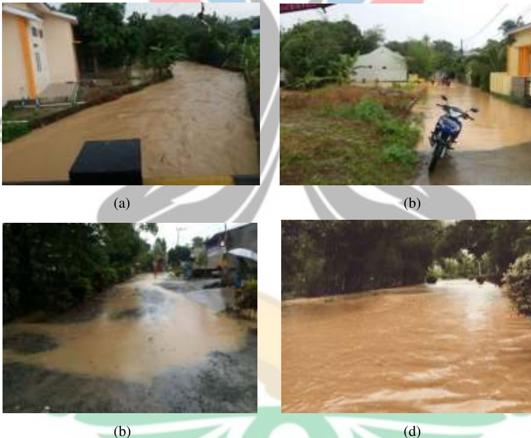
Gambar 1. 1 (a) Kondisi Saluran Primer (b) Kondisi Saluran Sekunder (c) Kondisi Saluran tersier (d) Kondisi Jalan Saat Terjadi Genangan dan Banjir
