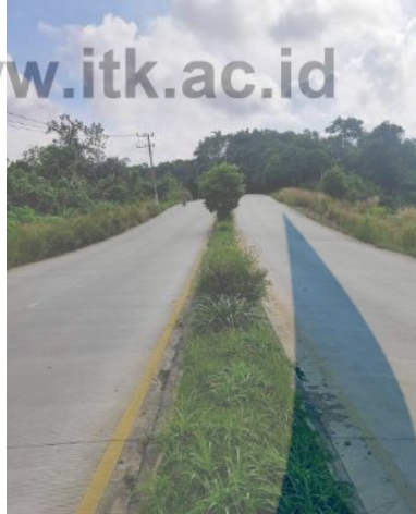
Gambar 4.13 Jalan Samarinda -Tenggarong (Primer, 2020)
