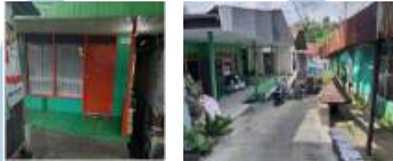
Gambar 1. 1 Kondisi Eksisting Bangunan Rumah di Kelurahan Muara Rapak Sumber : Survei primer, 2019
